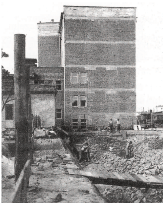
Rys. 3. Rozpoczęcie budowy obiektu Wydziału Elektrycznego w 1964 roku (budynek B)
