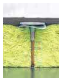
Rys. 2. Mata izolacyjna zamocowana do kanału wentylacyjnego przez zgrzewalny gwoździe, wyposażony w dodatkową podkładkę izolacyjną (źródło: materiały firmy NEWIR [1])
